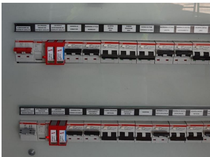
Figura 3 esempio di pannello in Lexan per copertura cablaggi interni
